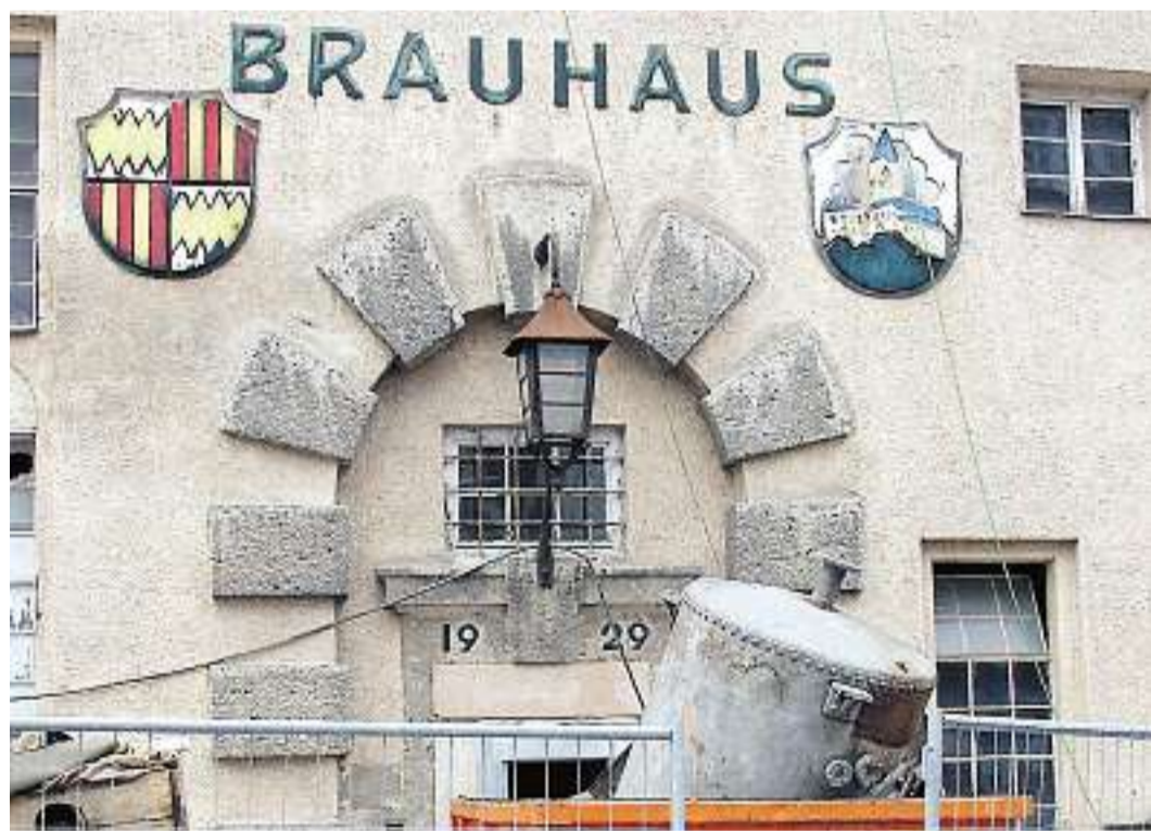
Über zehn Jahre wurde der Großteil des im Jahr 1929 errichteten Gebäudes nicht genutzt. Die Reste der alten Anlagen werden derzeit abmontiert.
