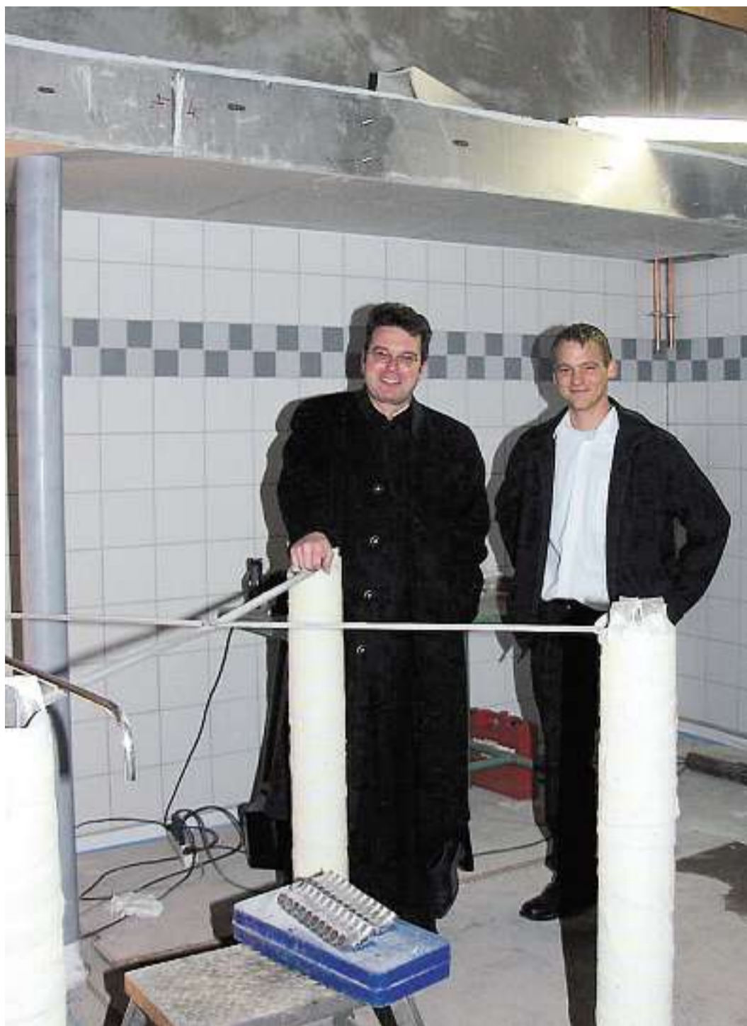
Unterwegs auf der Baustelle. Das künftige Sudhaus besichtigten Pater Lukas Wirth (l.) und der neue Scheyerer Braumeister Tobias Huber.
